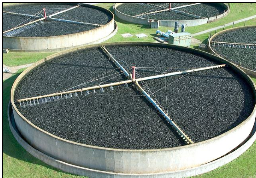
Hình 3.14. Bể lọc nhỏ giọt để xử lý nước thải đô thị [18]
